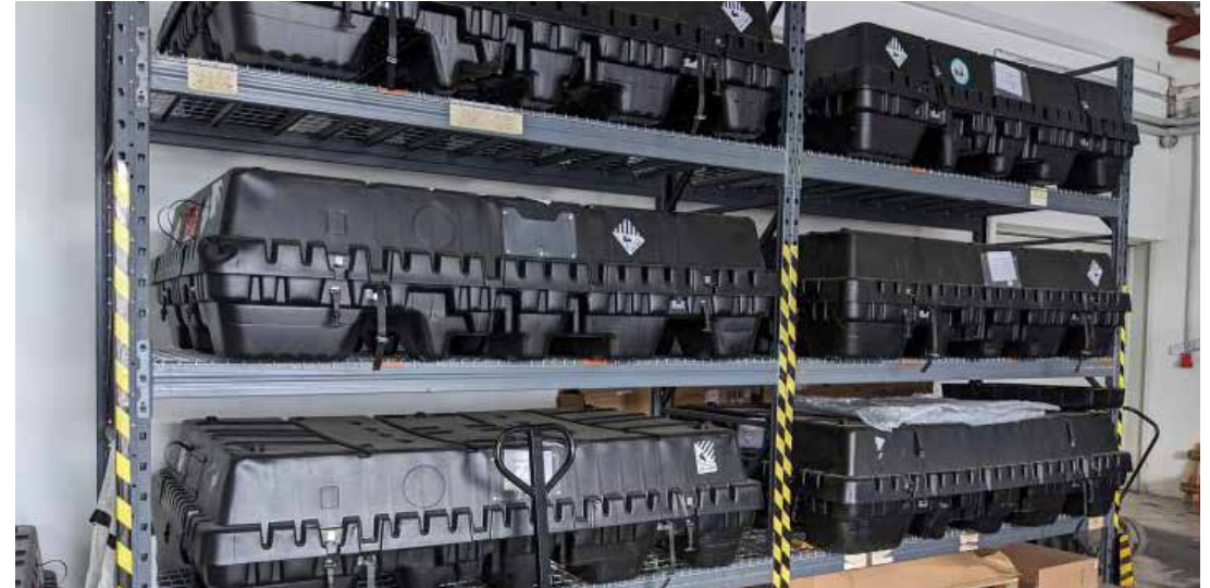
Batteries stockées sur rack
